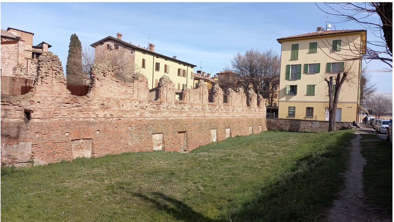
Foto 4 – Vista del vallo della Rocca e del percorso pedonale lato Via Matteotti (verso nord).
