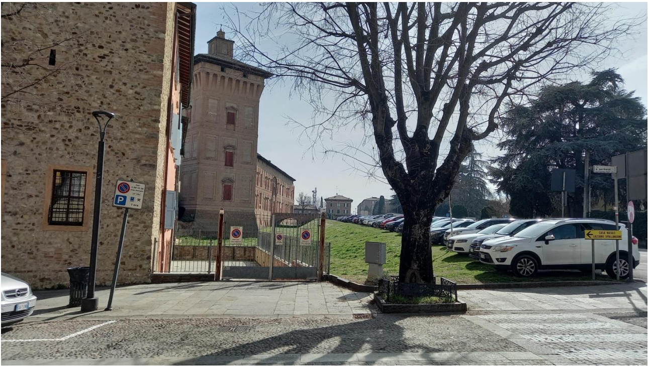
Foto 27 – Vista dell'accesso al vallo da Via Garibaldi.
