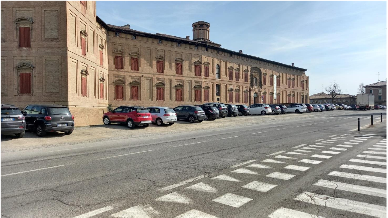
Foto 23 – Vista dell'incrocio tra Viale della Rocca e Via Risorgimento.
