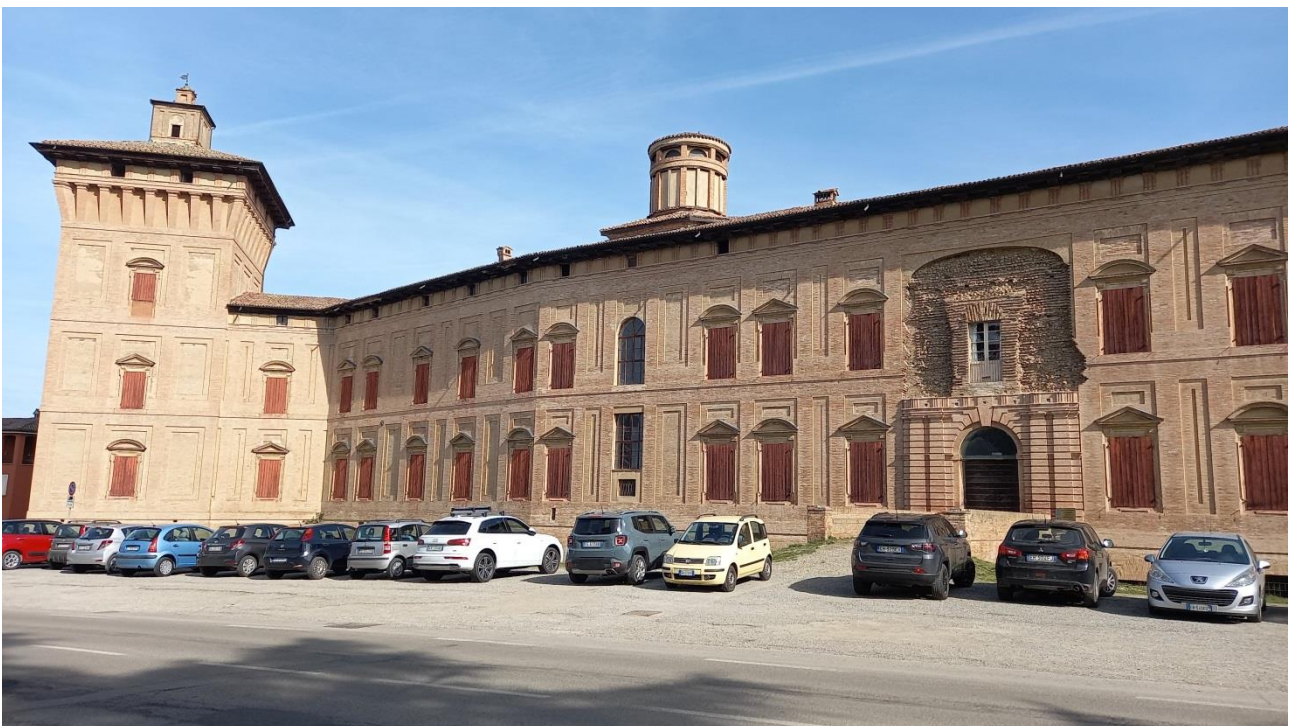
Foto 10 – Vista dell'accesso principale alla Rocca del Boiardo da Viale della Rocca.
