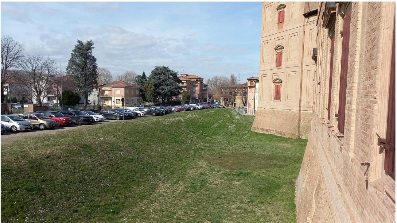
Foto 18 – Vista del vallo e della prospiciente area di parcheggio dall'ingresso principale della Rocca su Viale della Rocca (verso ovest).
